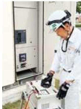
電気設備を停電させて日常点検の他に、測定機器などを使用して、接地抵抗測定、絶縁抵抗測定、保護継電器装置の動作試験などを行うとともに、活線状態では点検できない充電部の緩み、たわみ清掃などを実施します。
